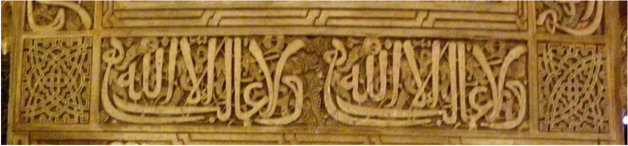
Figura 6. Caligrafía Cúfica y Lacería. Detalle del Palacio de Comares en la Alhambra de Granada (España).
